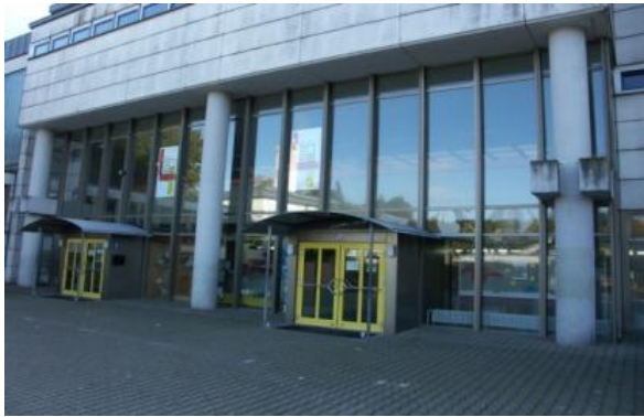
Abb. 5: Eingangsbereich vor der Sanierung.
