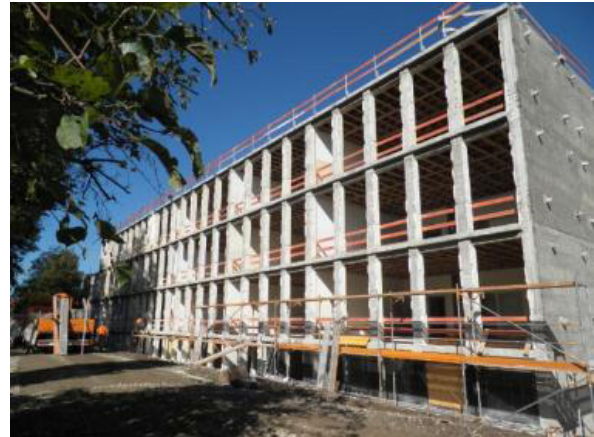
Abb. 2: Abbruch auf die tragenden Elemente.
