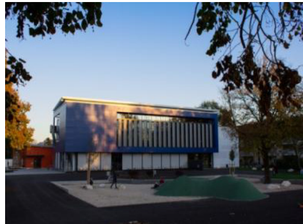
Abb. 4: Westansicht mit Verwaltung und Aula und effektiven Sonnenschutzpanelen.
