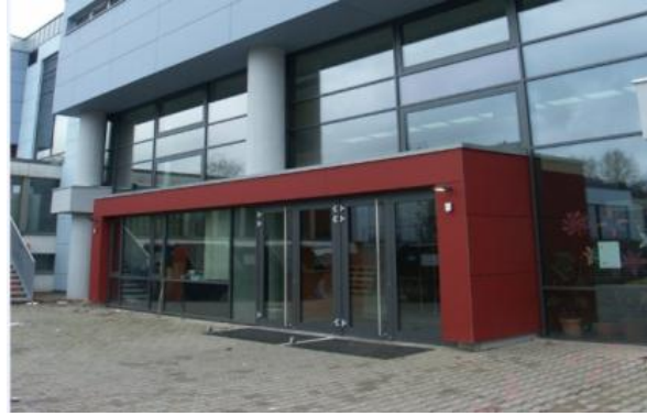
Abb. 6: Eingangsbereich nach der Sanierung.
