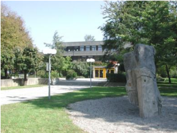
Abb. 1: Bestandsgebäude, erbaut 1972 bis 1974.
